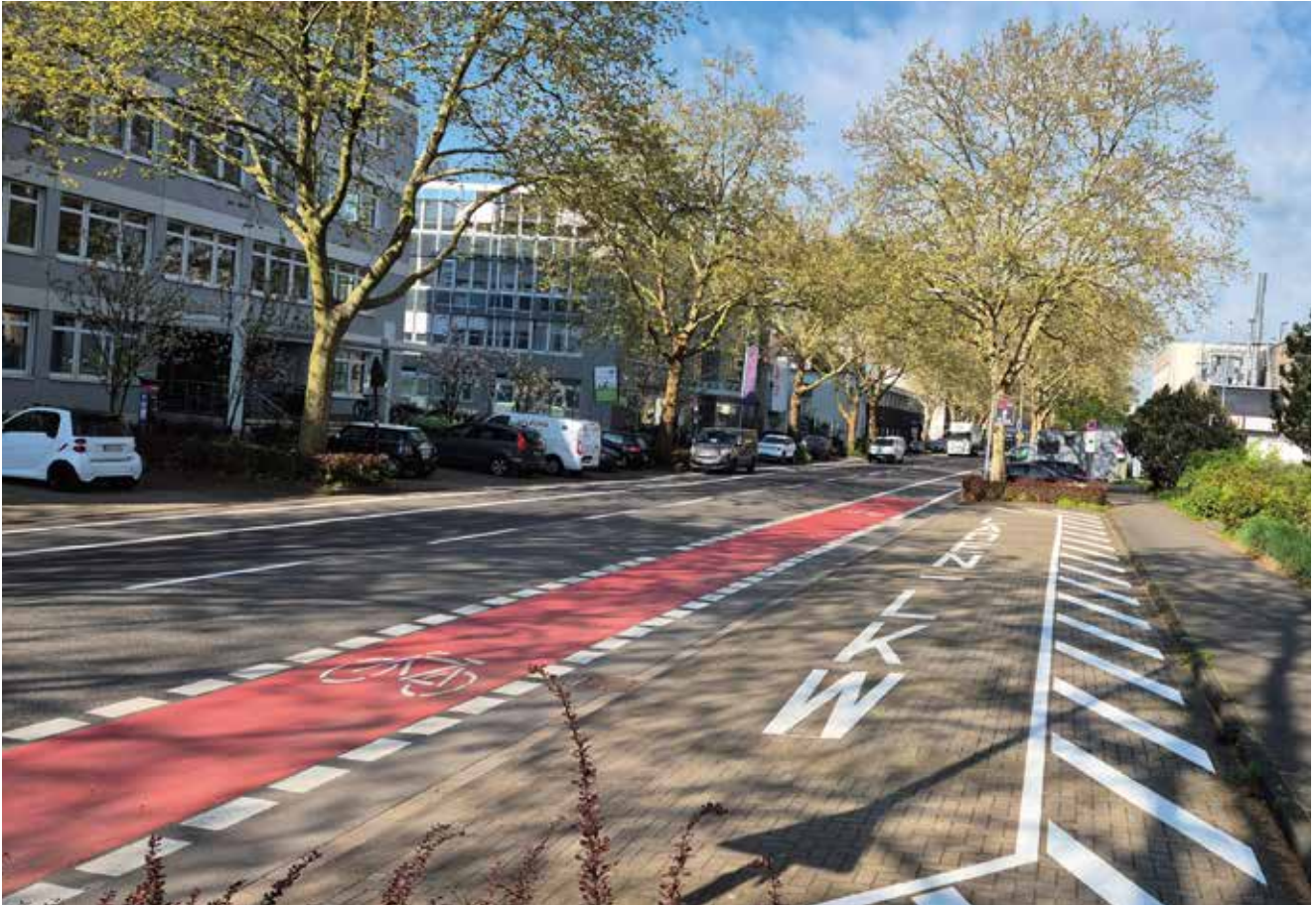
Fahrspur wird Radverkehrsanlage: Auf der Stolberger Straße entstand ein neuer Radfahrstreifen. Ein separater Seitenstreifen für den Lieferverkehr verhindert, dass haltende Fahrzeuge den Radverkehr behindern. – Foto: Stadt Köln
