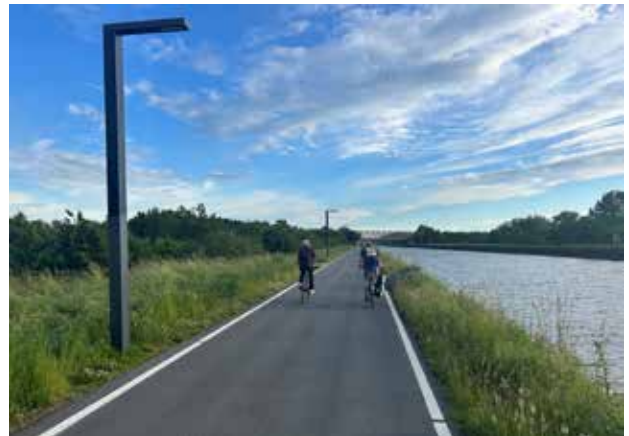
IGA-Radweg entlang des Kanals mit neuer Oberfläche und adaptiver Solarbeleuchtung, Foto: Stadt Lünen
