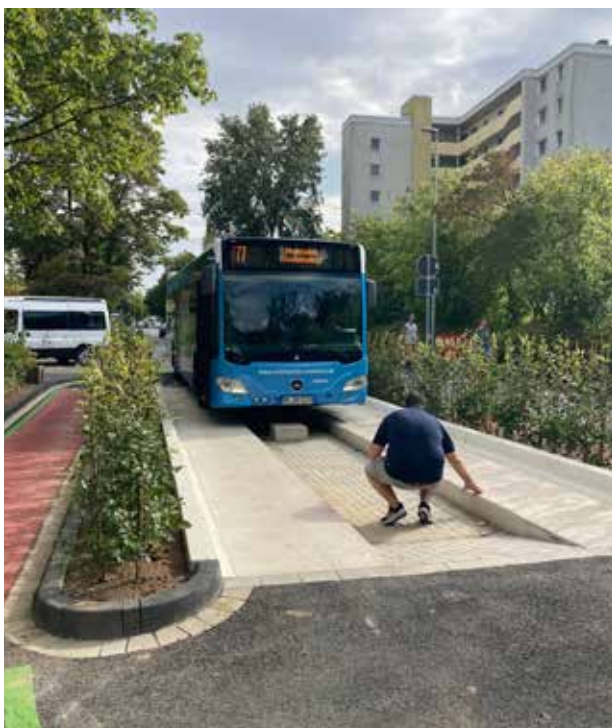
Radschnellweg im Bereich Benrather Straße im Bereich der Busschleuse. Foto: Stadt Monheim am Rhein / Stephanie Augustyniok
