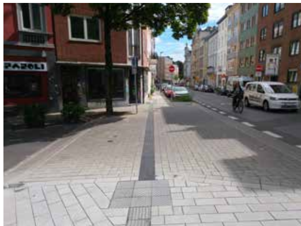
Barrierefreie Gehweg-Gestaltung im Einmündungsbereich, Foto: Stadt Aachen
