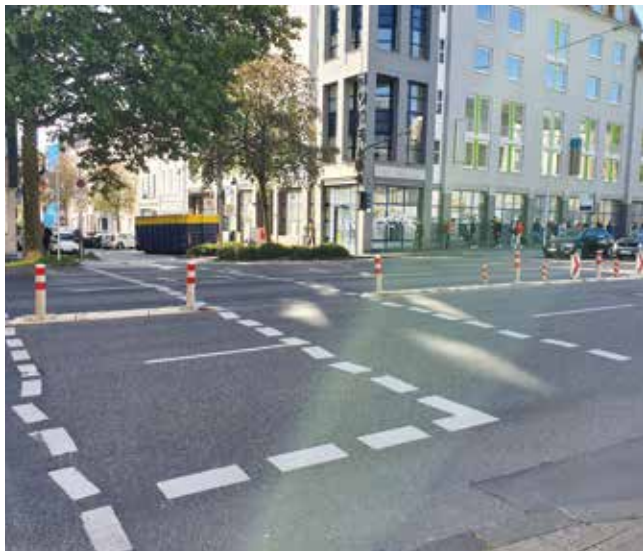
Signalisierte Radverkehrsfurt über die Hauptverkehrsstraße Jülicher Straße (vorher) – Foto: Stadt Aachen
