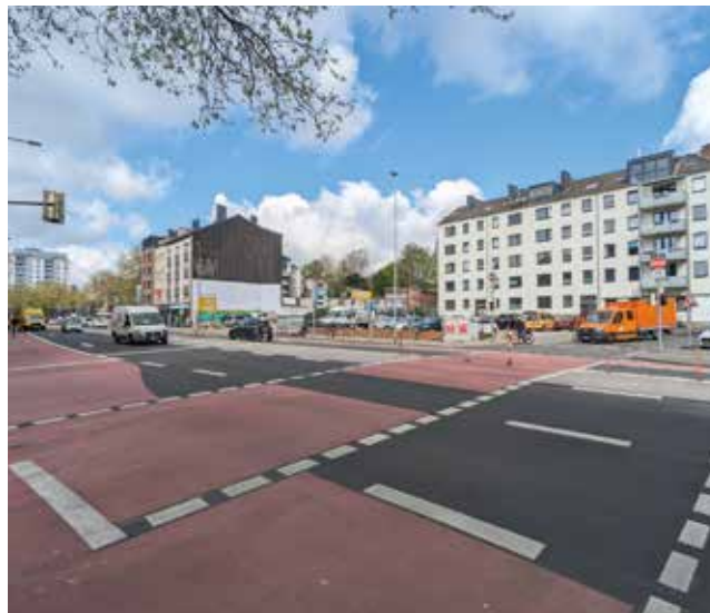
Signalisierte Radverkehrsfurt über die Hauptverkehrsstraße Jülicher Straße (nachher) – Foto: Stadt Aachen
