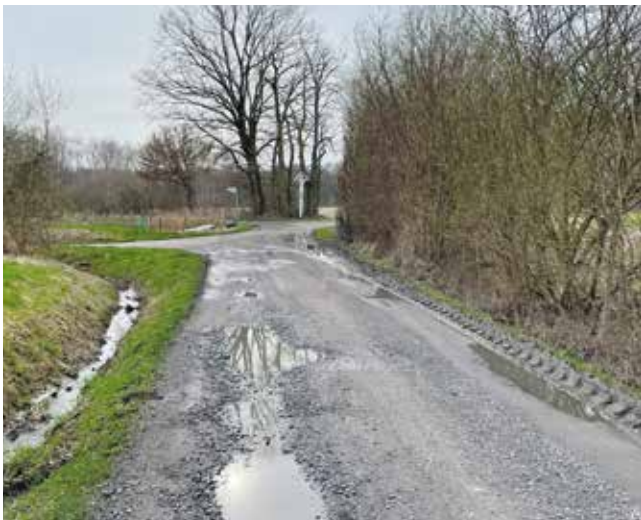
Teilstücke der unebenen Radwege im Bereich Pleistertimpen und Kasewinkel – hier der Blick auf das Wegekreuz Kasewinkel – wurden vom Amt für Mobilität und Tiefbau ab dem 25. März 2024 neu asphaltieren. – Foto: Stadt Münster/Amt für Mobilität und Tiefbau
