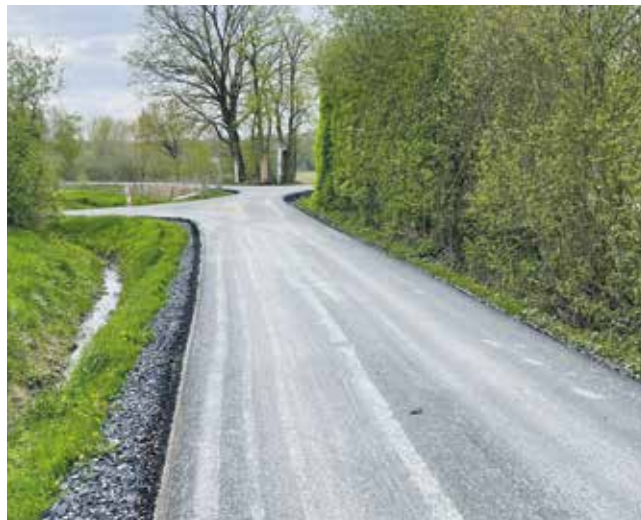
Der Fahrradweg Kasewinkel nach den Asphaltierarbeiten, kurz vor der Fertigstellung – Foto: Stadt Münster/Amt für Mobilität und Tiefbau
