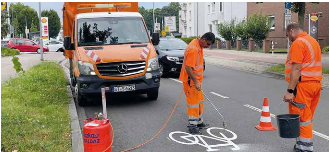
Zwei Straßenbauarbeiter fixieren die Piktogramme mit einem Gasbrenner. – Foto: Stadt Minden
