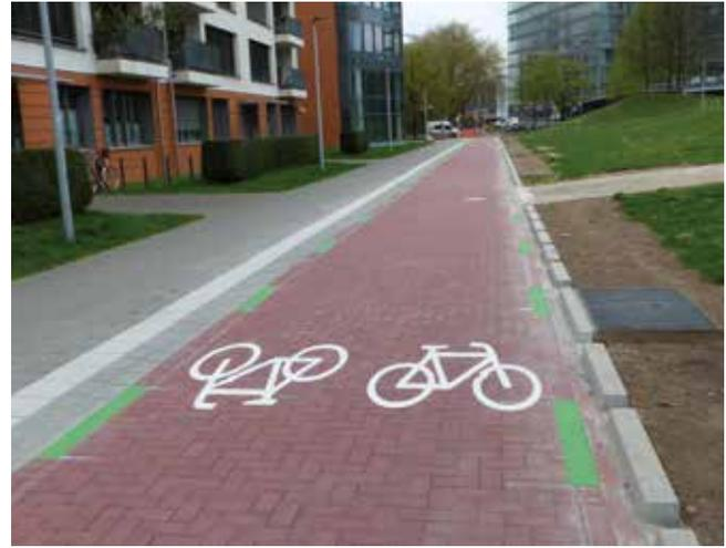
**Links: Ein neuer Zweirichtungsradweg verbindet seit März 2025 die Rheinuferpromenade mit der Moselstraße. Rechts: Zwischen Fürstenwall und Ernst-Gnoß-Straße wurde ein rot gepflasterter, barrierefreier Radweg mit weißem, taktilem Leitstreifen eingerichtet, der klar vom Gehweg abgesetzt ist.** – Fotos: Landeshauptstadt Düsseldorf, Amt für Verkehrsmanagement
