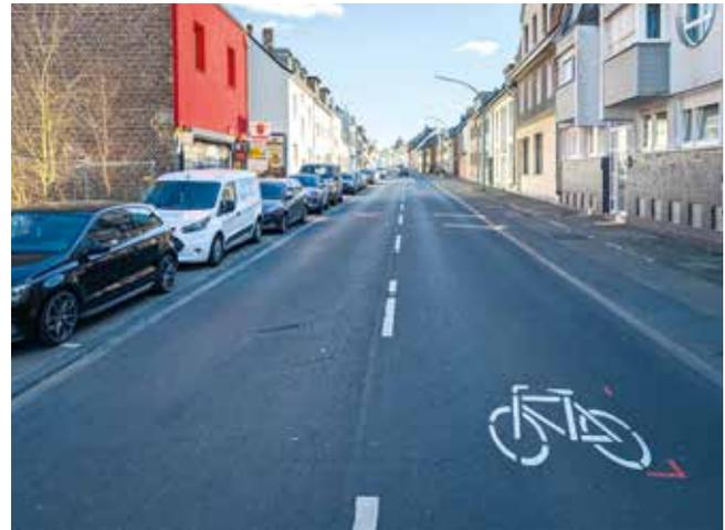
Es ist die erste von drei geplanten Piktogrammreihen, die im Rahmen eines Pilotprojektes getestet werden. Dabei wird der Kfz-Verkehr durch eine Reihe von auf der Fahrbahn aufgetragenen Fahrradsymbolen auf die Radfahrenden besonders aufmerksam gemacht. Piktogrammreihen zielen hauptsächlich darauf ab, die Verkehrssicherheit des Radverkehrs und das subjektive Sicherheitsgefühl der Radfahrenden zu verbessern.
